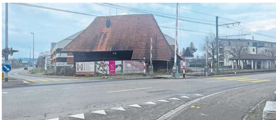
Das Hochstudhaus an der Holzikerstrasse in Hirschthal wird verschoben.
